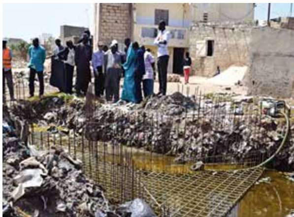
Les techniciens du projet sur le terrain
